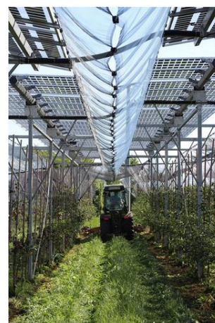
Agri-PV. Quelle: Fraunhofer ISE
