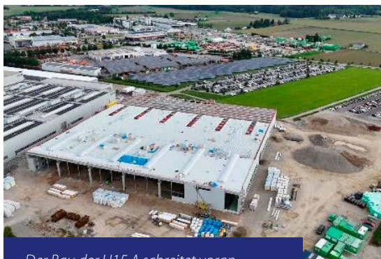
Der Bau der H15 A schreitet voran
