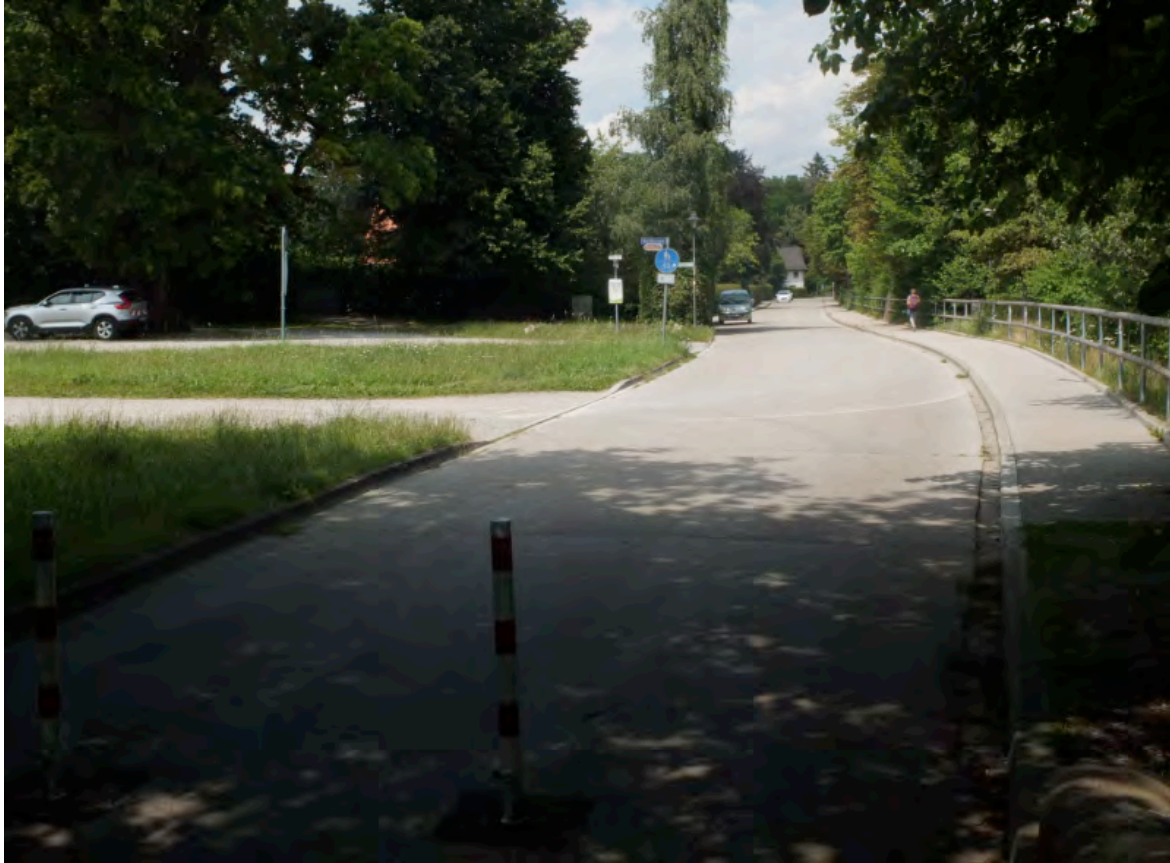
Georgenstraße von Süden her; Sperre für Geh- und Radweg nach Süden entlang der Mindel
