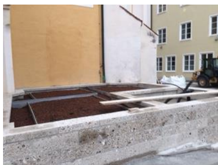
Die Konturen des Brunnens sind auf der Baustelle bereits zu sehen.
